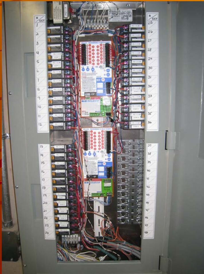
Panneau d'éclairage BacNet
