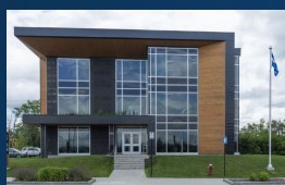
Immeuble de la MRC
