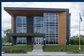
Immeuble de la MRC
